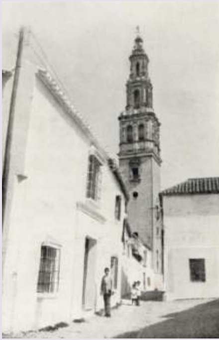
Torre iglesia de S. Gil. 1927
